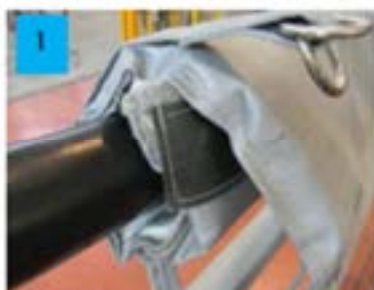
1 POSIZIONARE LA PROTEZIONE IGNIFUGA AL CENTRO DELLA GIUNZIONE
